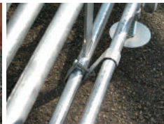
手すり枠を固定
