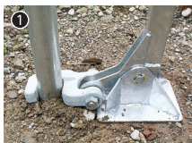
杭抜きをパイプにセット。
