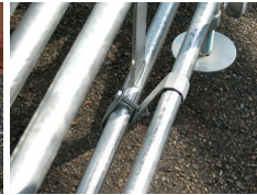
手すり枠を固定
