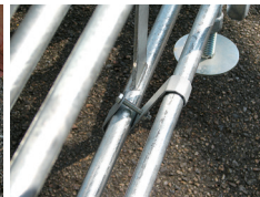
手すり枠を固定
